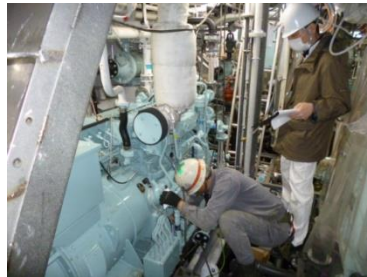
工事進捗確認
