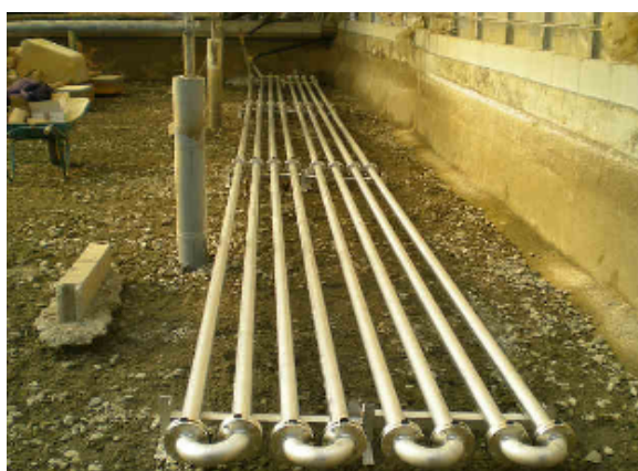
図Ⅲ. 2-16 池内の加温管を増設
