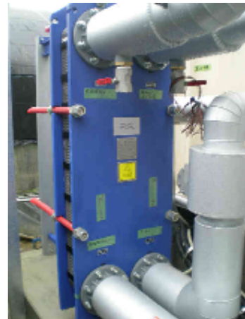
図Ⅲ. 2-12 (温水－補給水加熱器)
