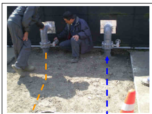
図Ⅲ. 2-24 補給水図 ← 補給水(30℃) 補給水(18℃) →
